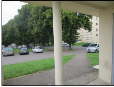
Photo N° 1090 AMIANTE CIMENT - -HALL EXTERIEUR Poteaux Coffrage perdu
