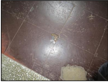
Photo N° 1088 REVETEMENT DE SOL --PALIERS +1 à +4 Planchers Dalles de sol 30x30
